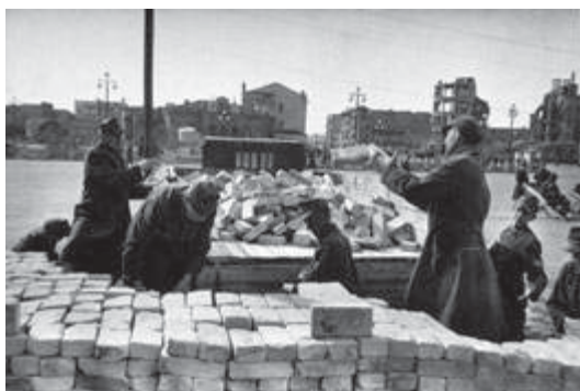
Німецькі військовополонені на відбудові зруйнованого міста
